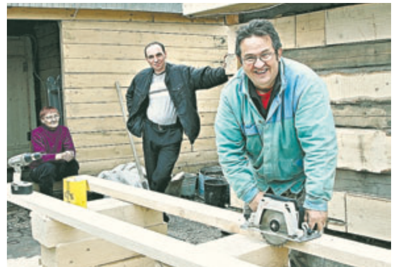
Юрий Шеин и Константин Квартин заново отстраивают дом пожилых супругов после пожара.
