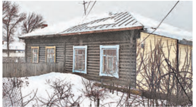
А это дом на улице Льнокомбинат, который попал в программу «Переселение граждан из аварийного жилищного фонда на 2013-2017 годы» и должен быть снесен.
