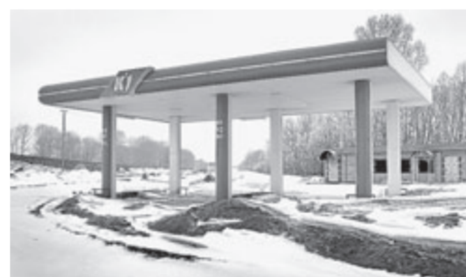
Заброшенная автозаправочная станция. Тальменский район.
