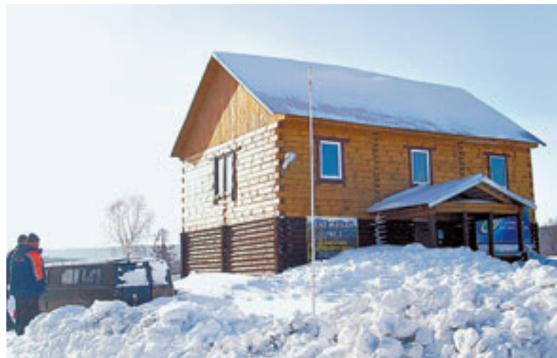
На строительство лыжной базы Кузнецовых был выделен грант в размере 1 млн. рублей, также предприниматели вложили собственные средства.
