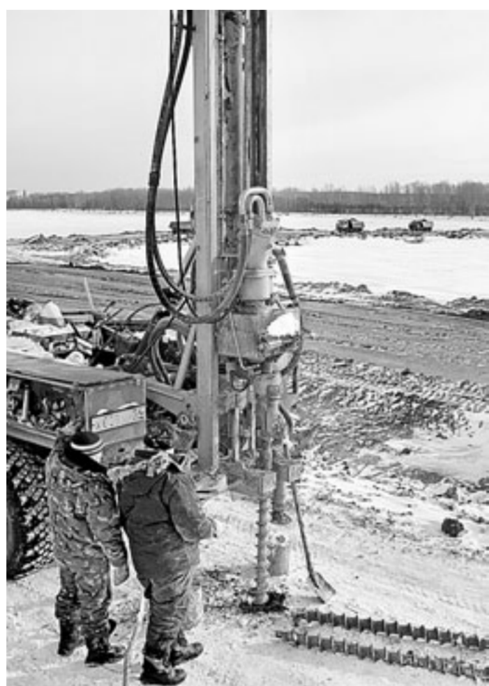
На строительстве дамбы работает тяжелая техника.
