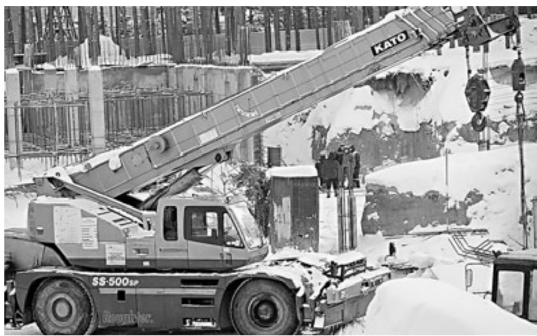
Строительные работы на новом перинатальном центре.
