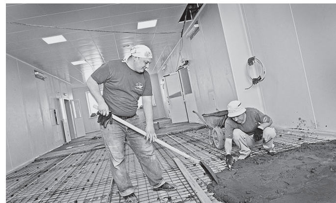
Монтировка полов – сложный и трудоемкий процесс.
