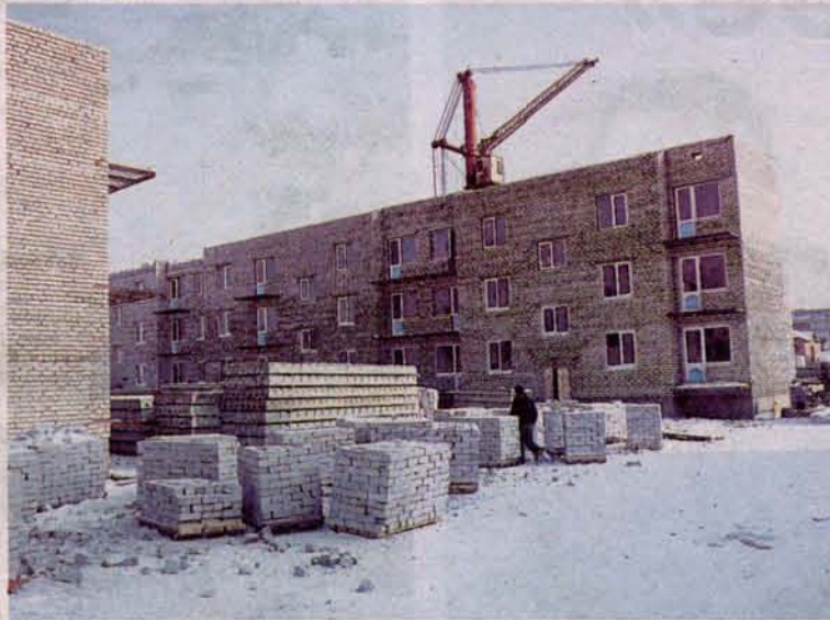
В южной части города строятся два новых дома для переселенцев.
