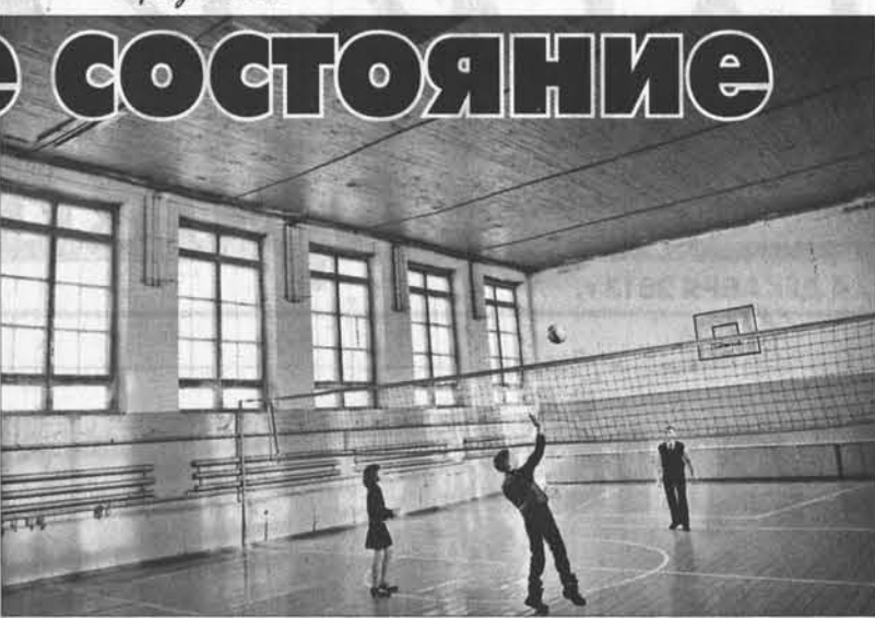
Ремонт кровли спортзала – первоочередная задача.
