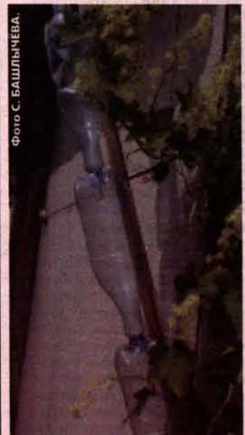
Водосток из пластиковых бутылок.
