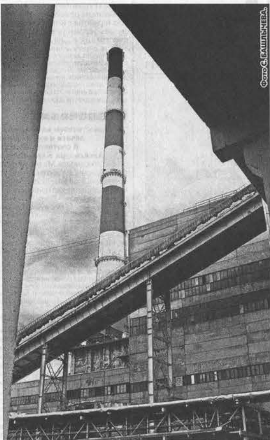
Барнаульская ТЭЦ-3 - главная «печка» краевого центра.
