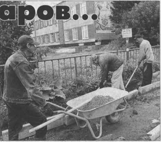
На центральных улицах Залесово прокладывают новые тротуары.
