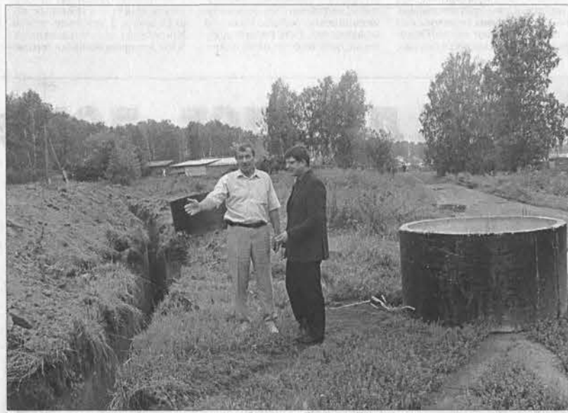
Александр Романов и Александр Плассев: «Первая траншея для нового водопровода».
