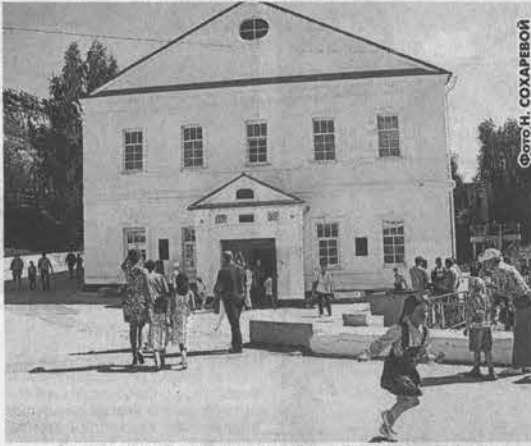
Этот заводской корпус помнит Ивана Полузунова. Наш великий земляк работал на Кольванском моделильном заводе в 1761-1762 годах.
