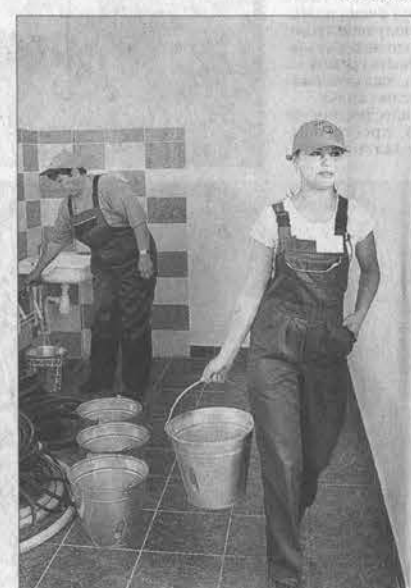
Без воды в работе штукатурка — нигде. С полным ведром — Ксения Нурметова из команды ПУ-16.
