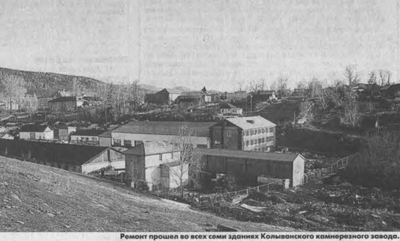
Ремонт прошел во всех семи зданиях Кольванского камнерезного завода.
