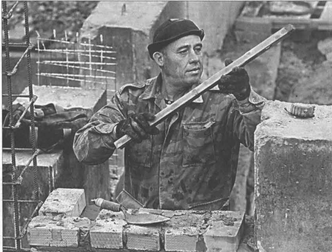
Александр Шкурнов – опытный каменщик, выполняет работу качественно, надежно.
