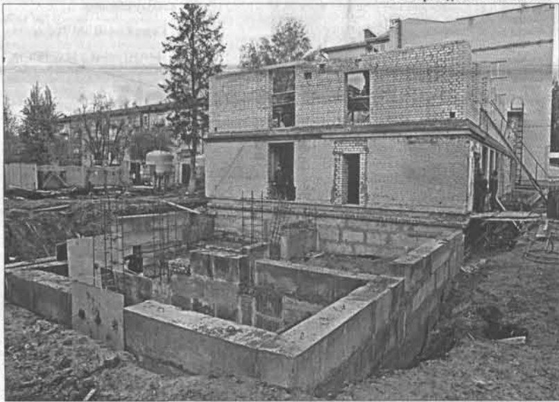
Пока основные работы на реконструируемом объекте ведутся в котловане.
