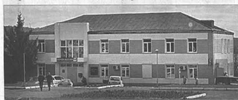
Так после капитального ремонта выглядит здание местного почтамта.
