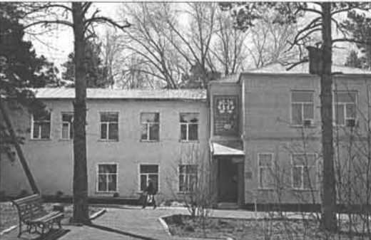
На ремонт главного корпуса потрачено около 21 миллиона рублей.
