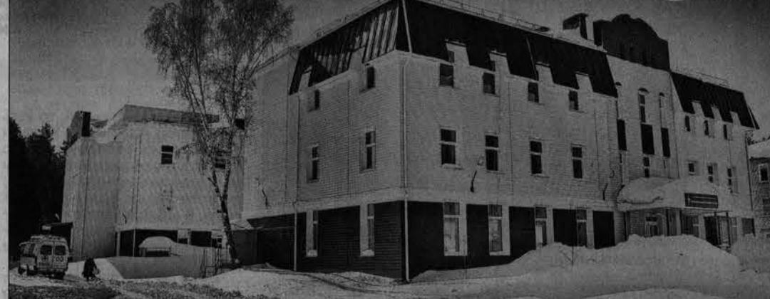
Так после капитального ремонта выглядит Ребрихинская ЦРБ.
