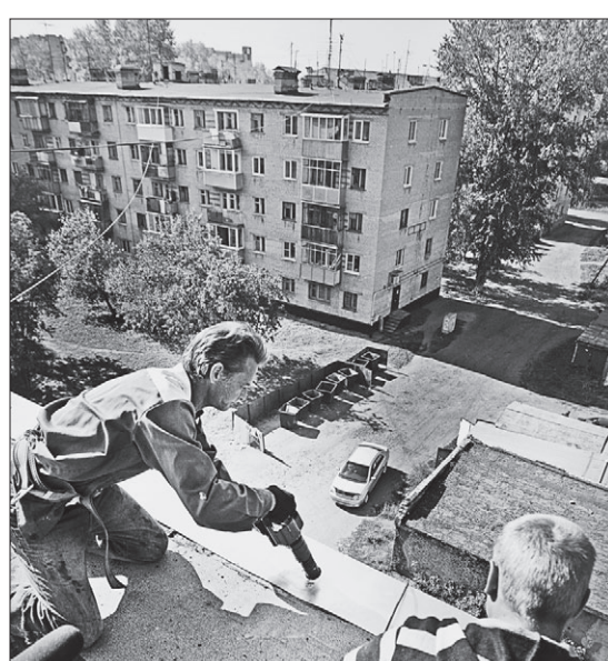
Пятиэтажка на улице Красногвардейской, 16: замена кровли.
