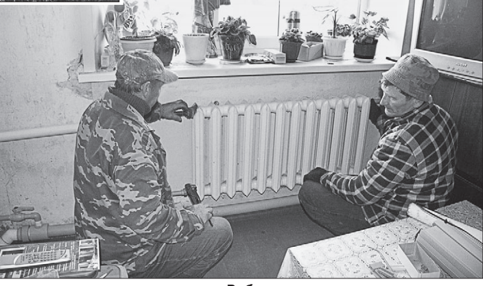
Работы идут и в квартирах жильцов.
