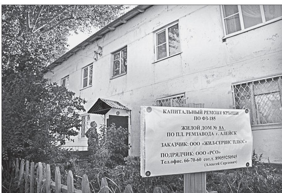
Замена крыши стоит около 800 тысяч рублей.
