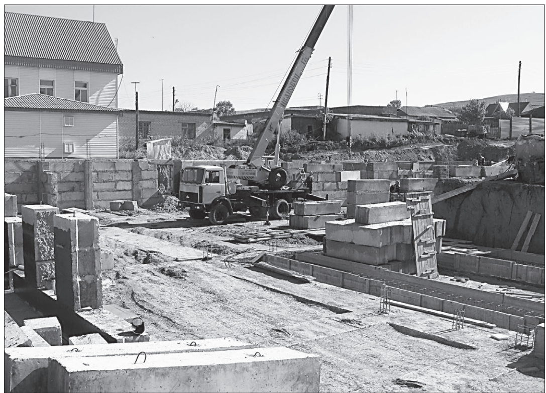
Будущая пристройка к зданию ЦРБ: пока возводится нулевой цикл.
