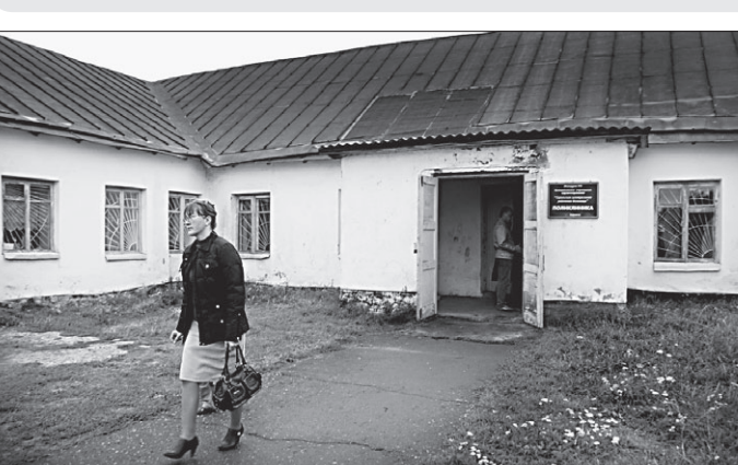
Здание старой поликлиники.
