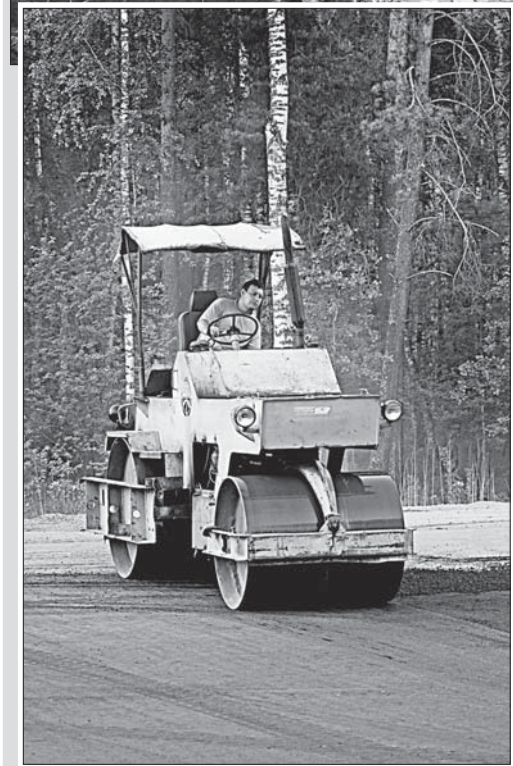
Полным ходом идет асфальтирование подъездов к мосту.
