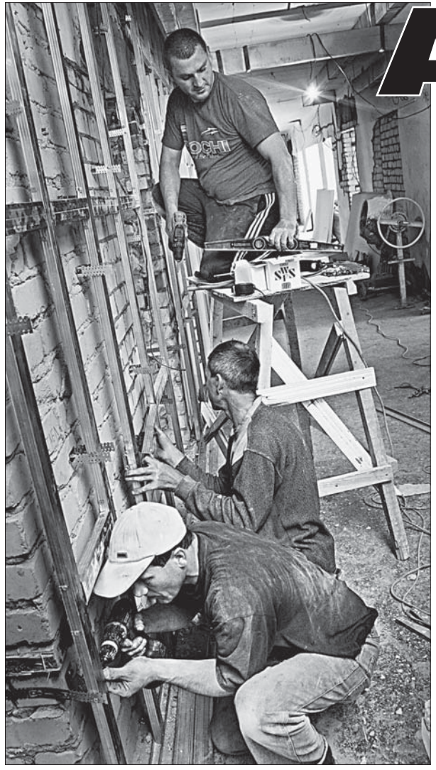
Работы по реконструкции больницы идут полным ходом.
