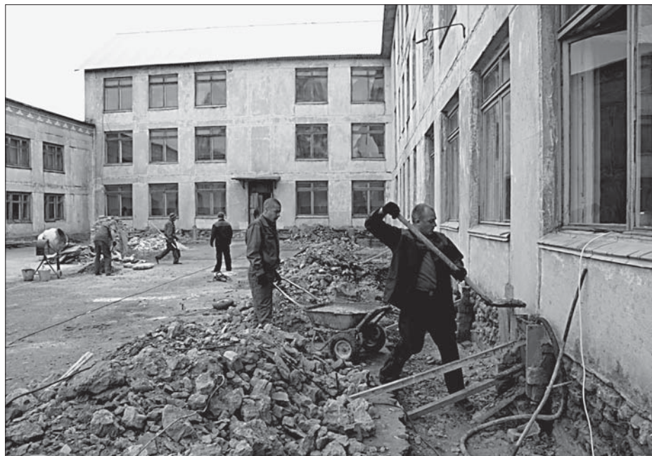
Каждой школе нужен крепкий фундамент.
