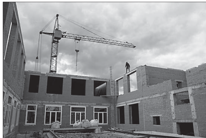
Новая школа в Налобихе строится ударными темпами.
