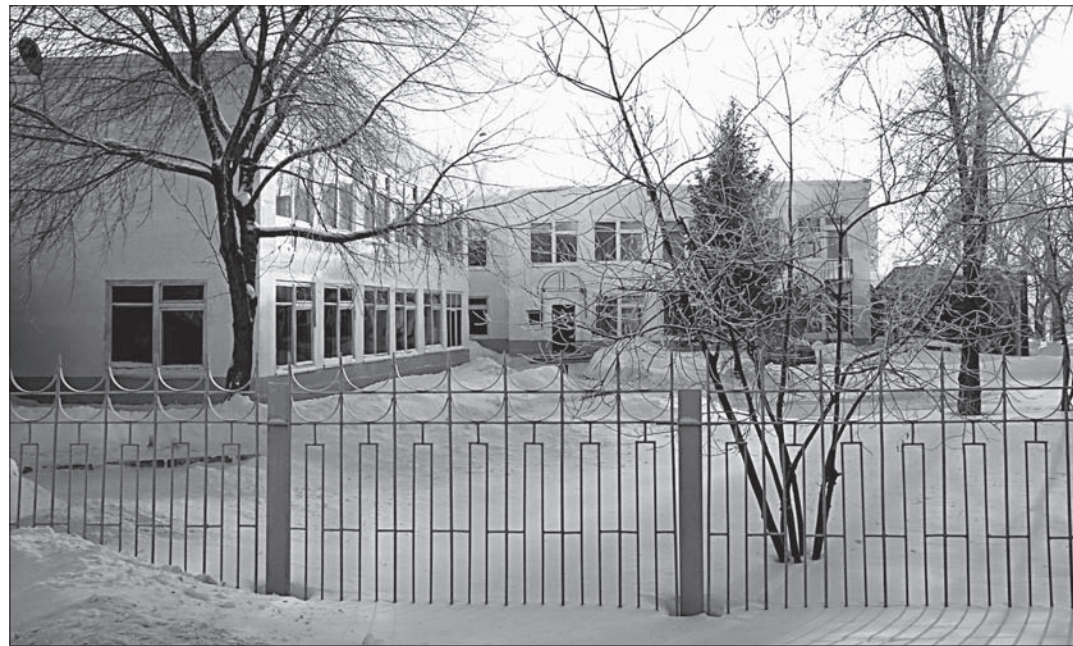
До ремонта это здание стояло с облупившейся штукатуркой, теперь радует глаз.
