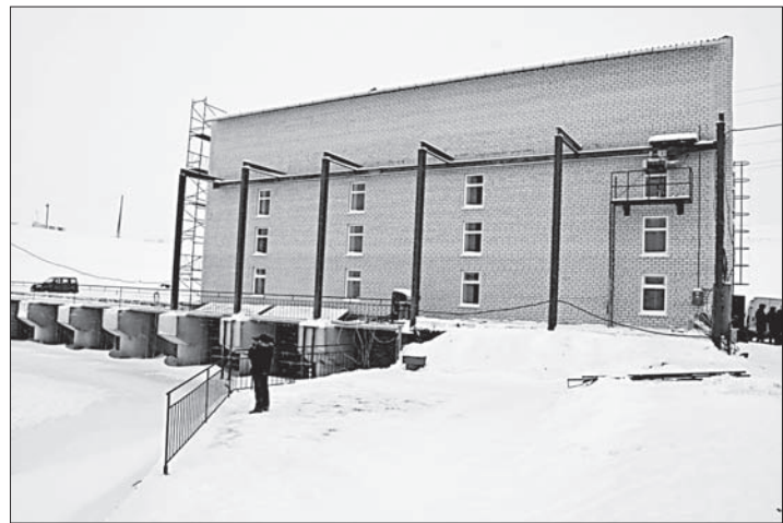
Седьмой пусковой комплекс – последний объект мелиоративной стройки – сдан в эксплуатацию.
