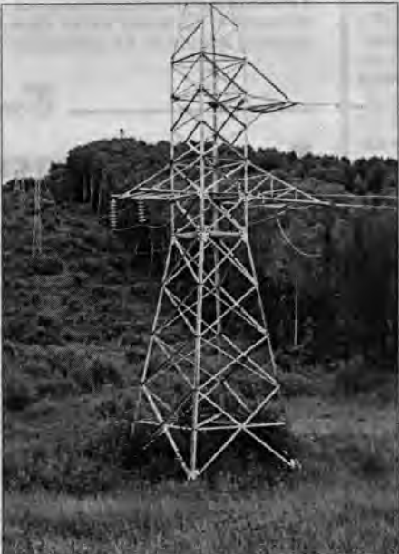
Трасса состоит из металлических опор, сделанных по современным технологиям. Кстати, для защиты от воров болты, гайки, уголки обварены. Провода, это мало помогает: еще в ходе строительства жулики пытались утащить провода и успели нанести ущерб на 300 тысяч рублей.
