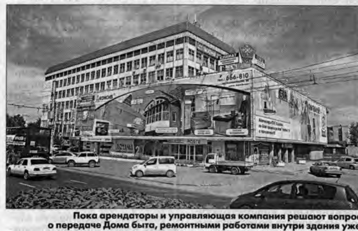
Пока арендаторы и управляющая компания решают вопрос о передаче Дома быта, ремонтными работами внутри здания уже никто не занимается.
