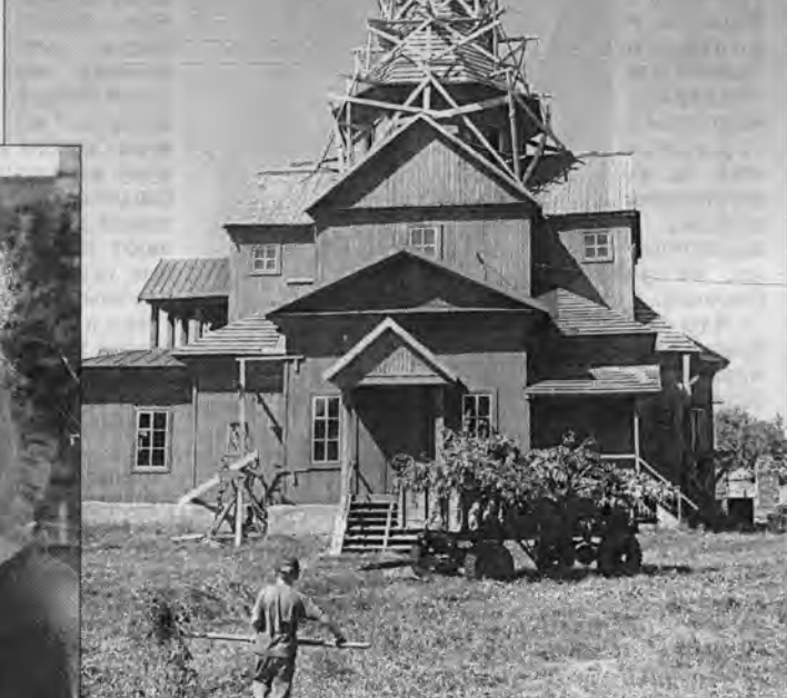
Покровский храм в Быстром Источе снова в строительных лесах.
