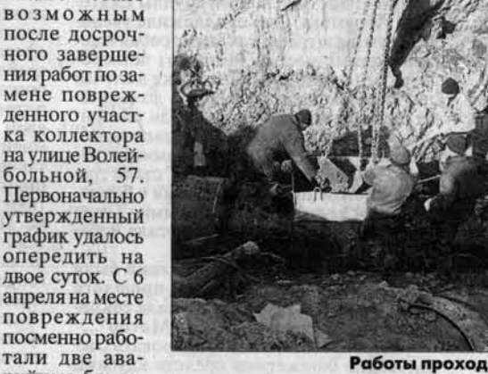
Работы проходили на глубине.
