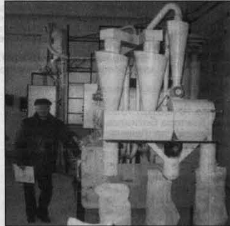
На монтаже МЕЛЬНИК 400 ЛЮКС Николая Роснякова, село Плотники Кировской области, март 2005.
