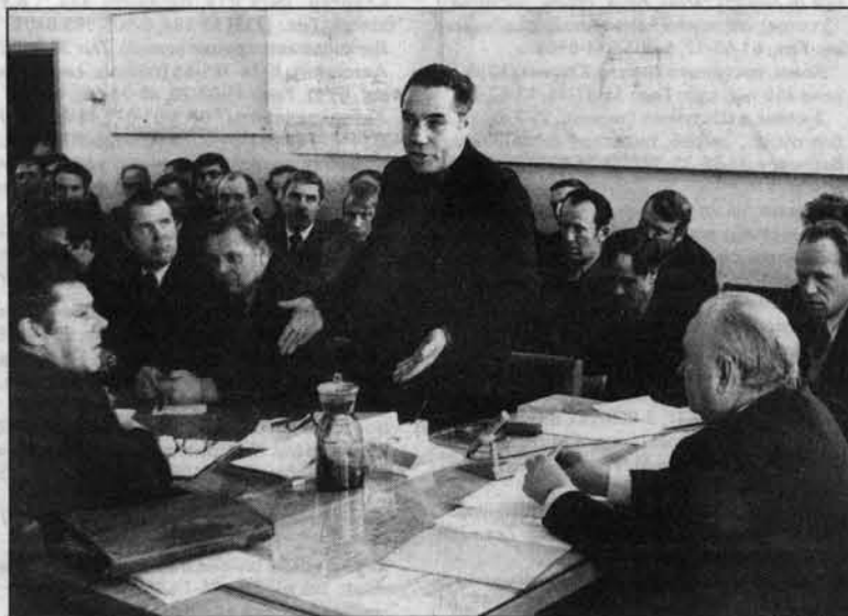
Штаб стройки Алтайского коксохима: докладывает начальник Главалтайстроя И.Копелиович.
