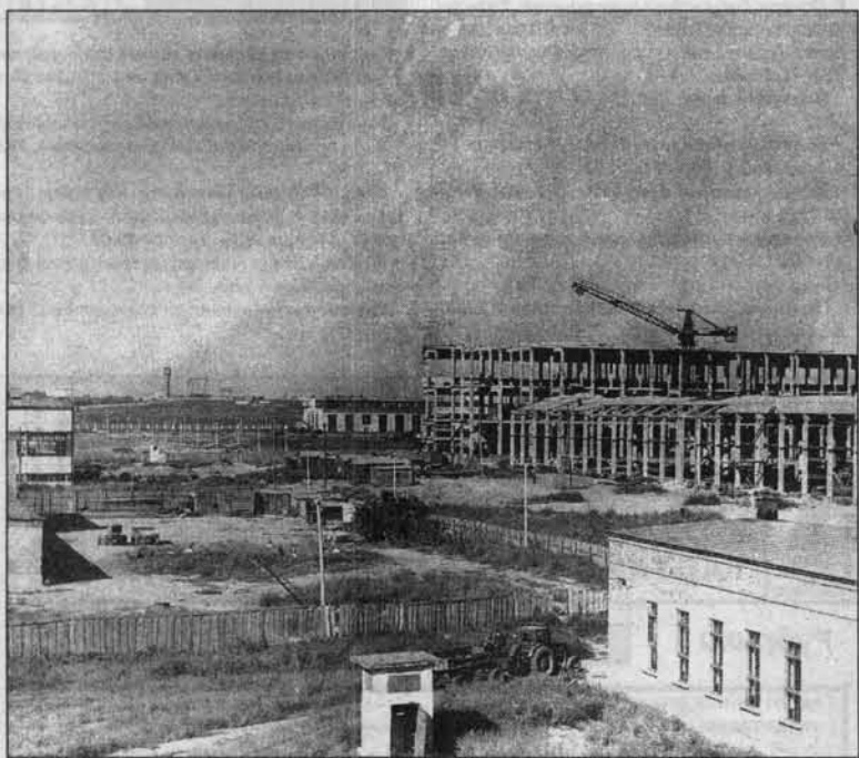
1968 год: строится главный корпус Барнаульского шинного завода.
