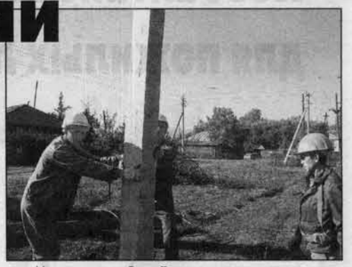
Монтажники Алтайского участка установили очередную электроопору за десять минут.
