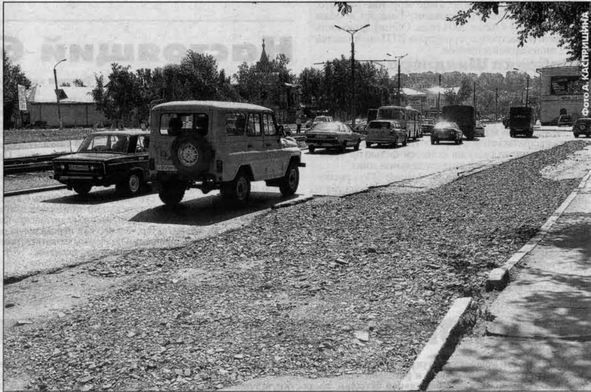
Вот так выглядит проспект Красноармейский между улицами Короленко и Гоголя. После завершения ремонтных работ.
