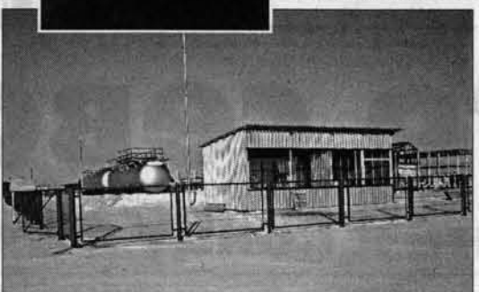
Строющийся газонаполнительный пункт с автозаправочной станцией.
