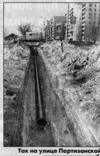
Так на улице Партизанской шла укладка труб.
