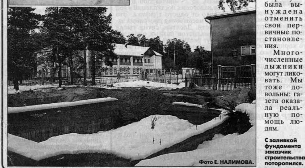
С заливкой фундамента заказчика строительство поторопилось. Фото Е. НАЛИМОВА.
