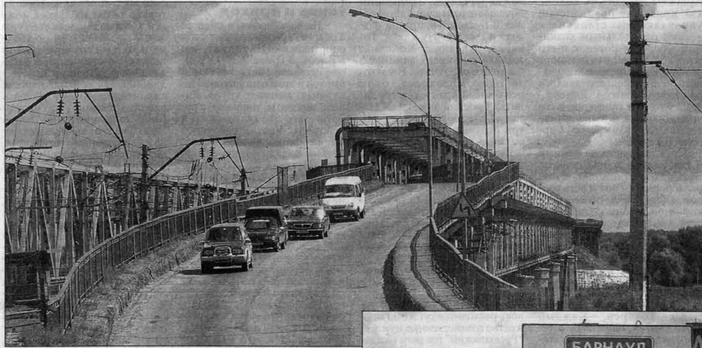
После ремонта въезд на мост будет выложен специальными плитками, которые уменьшат нагрузку.
