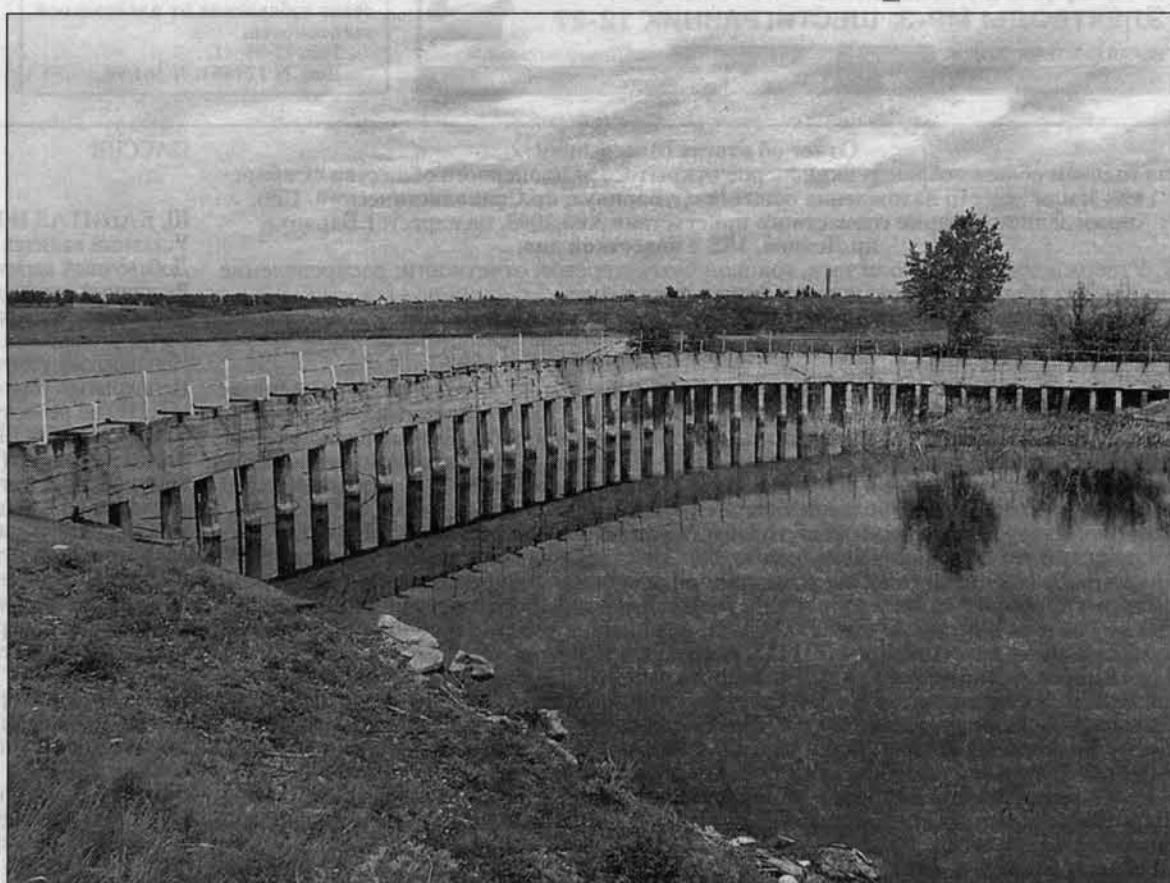
Клепечиха. Немалые средства идут на ремонт гидротехнических сооружений.
