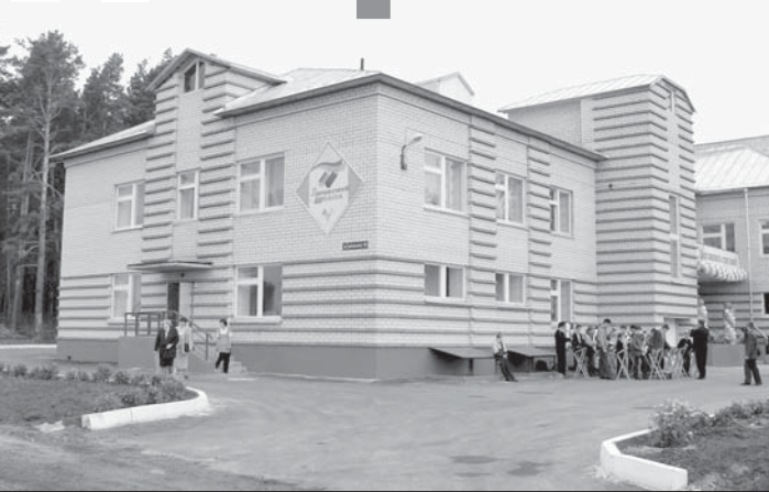
Мешало отсутствие средств, но все же благодаря совместным усилиям района, города и края строительство удалось завершить к учебному году. Строителям помогли родители, учителя и школьники. Они не только очищали коридоры и классные комнаты от строительного мусора, но и благоустроили территорию, ухаживали за растениями, украшали здание. Так что к главному своему празднику школа обрела вполне обжитой вид: на окнах цветы и шторы, в фойе книжная выставка "Алтай - земля золотая", посвященная 65-летию края, и стенд "Символы нашей Родины" с информацией о флаге, гербе и гимне России, гербе Барнаула.
