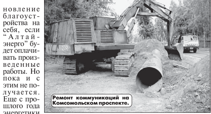
Ремонт коммуникаций на Комсомольском проспекте.
