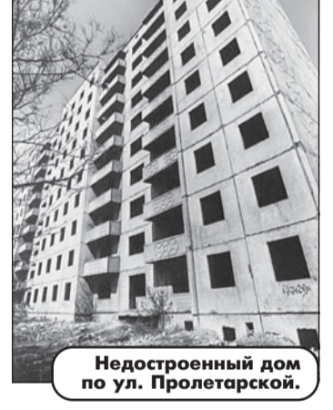
Недостроенный дом по ул. Пролетарской.
