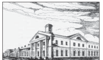
Павловская фабрика Барнаульского сереброплавильного завода. Начало XIX века.
