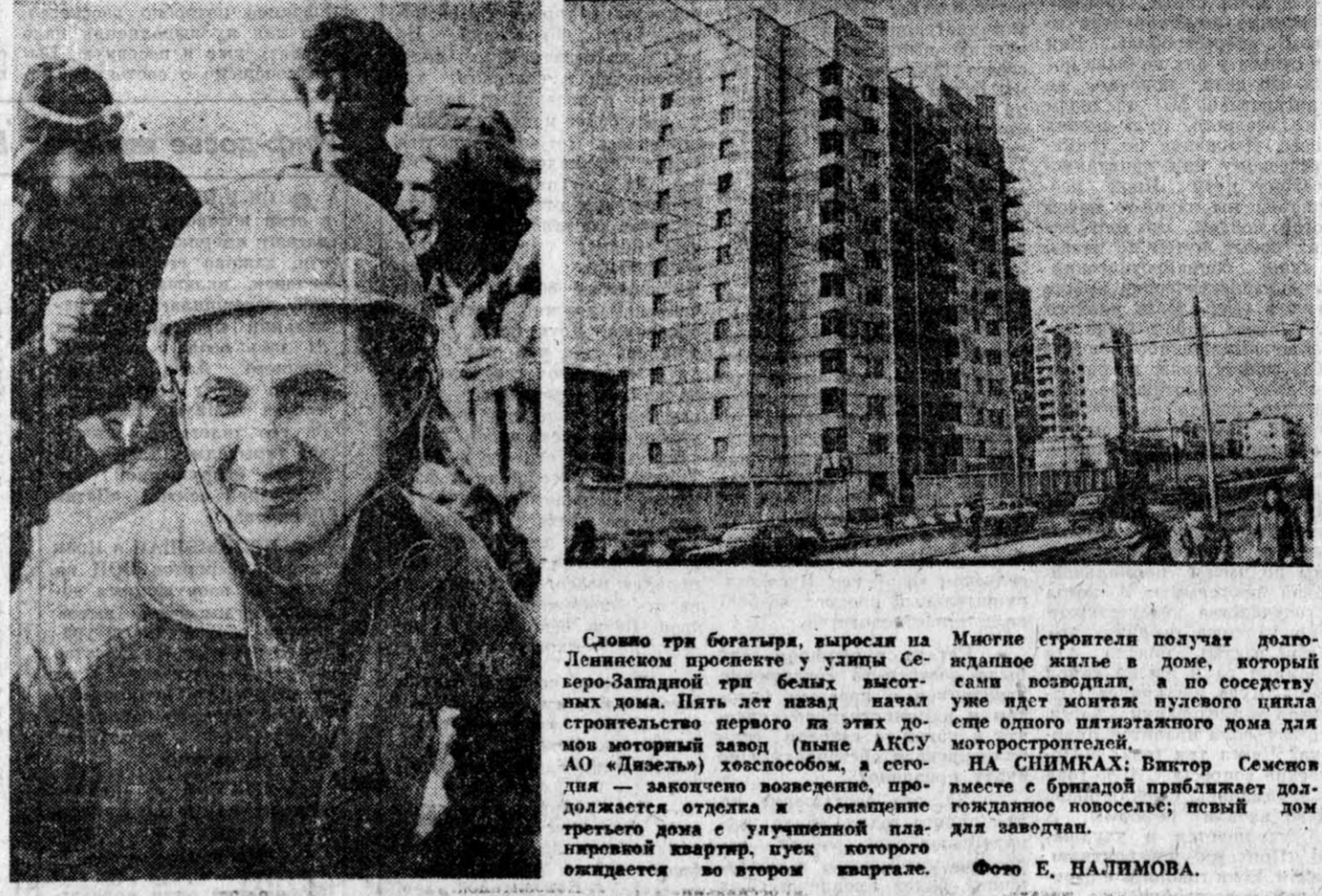
Словно три богатыря, выросли на Ленинском проспекте у улицы Серено-Западной три белых высотных дома. Натя лет назад начал строительство первого из этих домов моторный завод (ныне АКСУ АО «Дазель») хосспосовом, а сегодня — закончено возведение, продолжается отводка и оснащение третьего дома с уютнейшей планировкой квартир, пуск которого ожидается во втором квартале.
