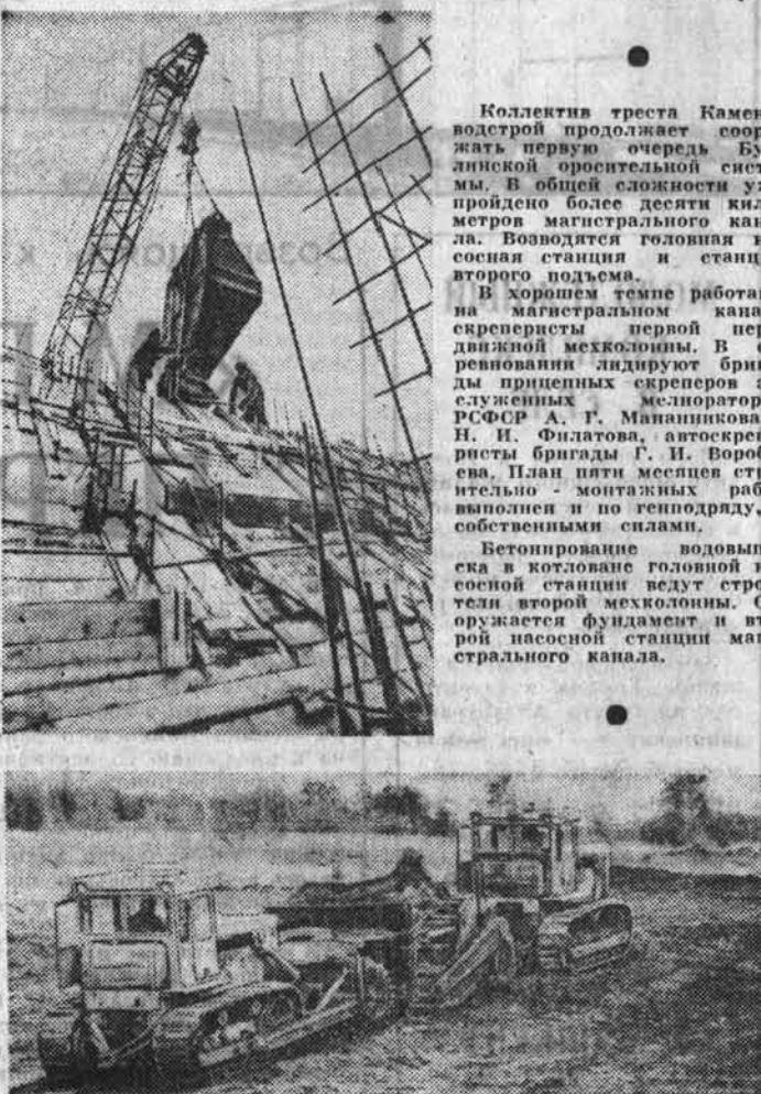
Коллектив треста Каменистой продолжает сооружать первую очередь Курганской оросительной системы. В общей сложности уже пройдено более десяти километров магистрального канала. Возле этой головной насосной станции и станции второго водсема.
