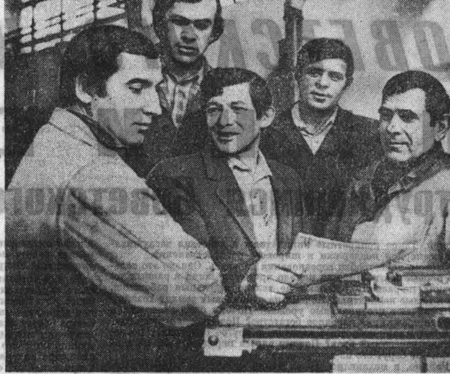
НА СНИМКЕ: монтажники В. В. Попов, В. И. Наумов, бригадир Г. Н. Лещев, А. И. Крапивин и В. А. Колесников.
