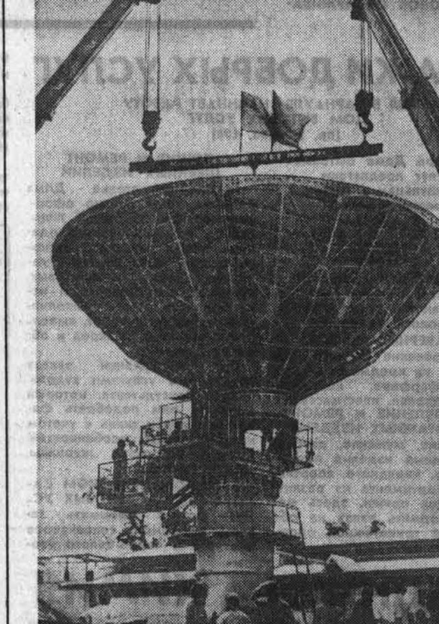
При техническом содействии Советского Союза в городе Хошимине закончено сооружение наземной станции космической связи «Лотос-2». С вводом ее в строй телезрители юга страны получат возможность смотреть передачи из СССР. НА СНИМКЕ: монтаж параболического зеркала наземной станции космической связи в Хошимине.
