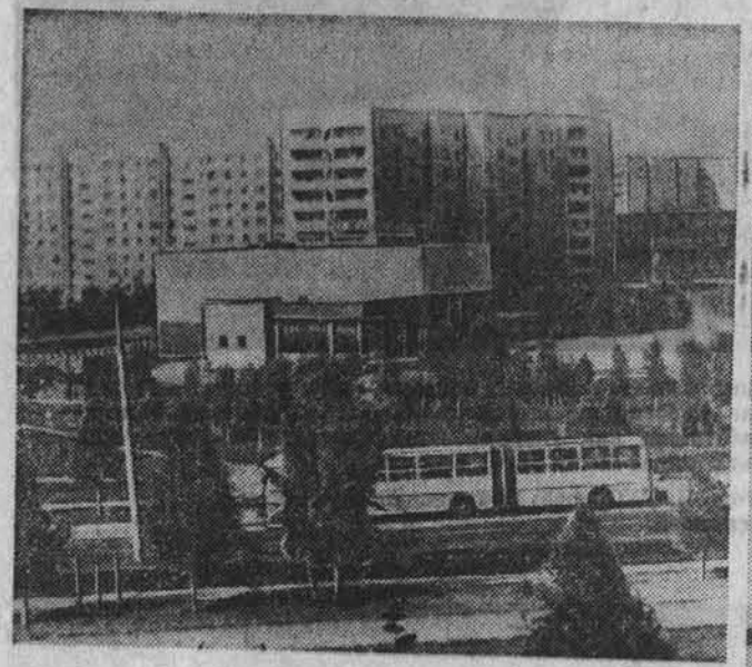
НА СНИМКАХ: кинотеатр «Искра»; первая рабочая смена инженера В. Степановой и старшего инженера В. Жирнова.
