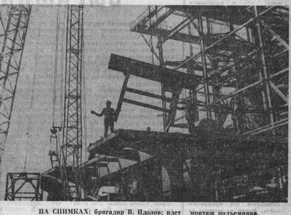
НА СПИМКАХ: бригадир В. Идолов; идет монтаж подземника.
