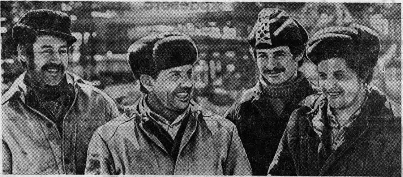
Укрупненную комсомольско-молодежную бригаду Александра Зеленикина в тресте Алтайкоксострой по праву называют одной из лучших. Большой вклад внес передовой коллектив в строительство первой коксовой батареи. И сегодня плотники-бетонщики идут в авангарде социали-
